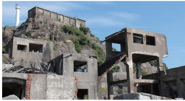
端島(通称・軍艦島)は、明治時代から急速な発展をとげた炭鉱業に関する文化遺産として二〇一五年に世界遺産登録された無人島です。オリエントは同年、端島の護岸施設現況調査や生産施設の調査に携わってきました。調査を行った生産施設は、通常立入禁止エリアとされており、繁栄当時のまま残された巨大な建物は一部が崩壊し、周囲はコンクリートやガラス、鉄筋などががれきりと化し、そこに人の営みがあったことを感じさせるものなどが散乱する異様な雰囲気でした。また、島へのアクセスが制限されたことや、島内に電源がないことなど、調査には多くの制約もありましたが、ドローンや三次元レーザースキャナーなど最新技術を用い、建物の破損状況の調査、コンクリートや鉄筋などの材料調査、試掘調査、施設周辺の測量等により保存整備のためのデータ収集する業務を行いました。
